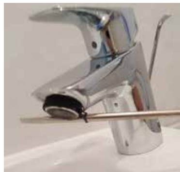
Slika 9b : Privijanje in odvijanje mrežice vodovodne pipe.
